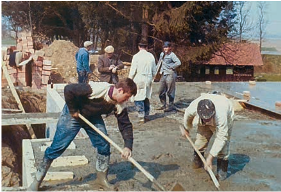
Fundamentlegung Sportheim (im Hintergrund die damalige Umkleidekabine der Fußballer)
