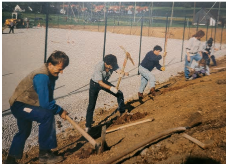
Bau der ersten zwei Tennisplätze 1994
